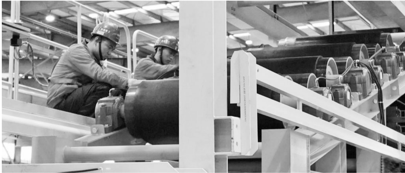
近日，由铁建重工自主研发的大型隧道连续皮带机在长沙完成安装调试。
