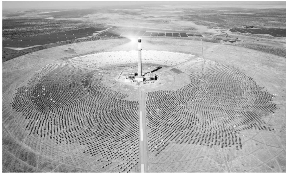
在南非北开普省拍摄的南非红石100兆瓦塔式熔盐光热电站项目(无人机照片)。 新华社记者 张誉东 摄
