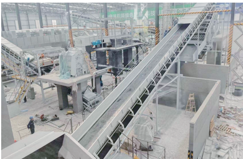
图为成都会展垃圾分类处置、分解现场。
