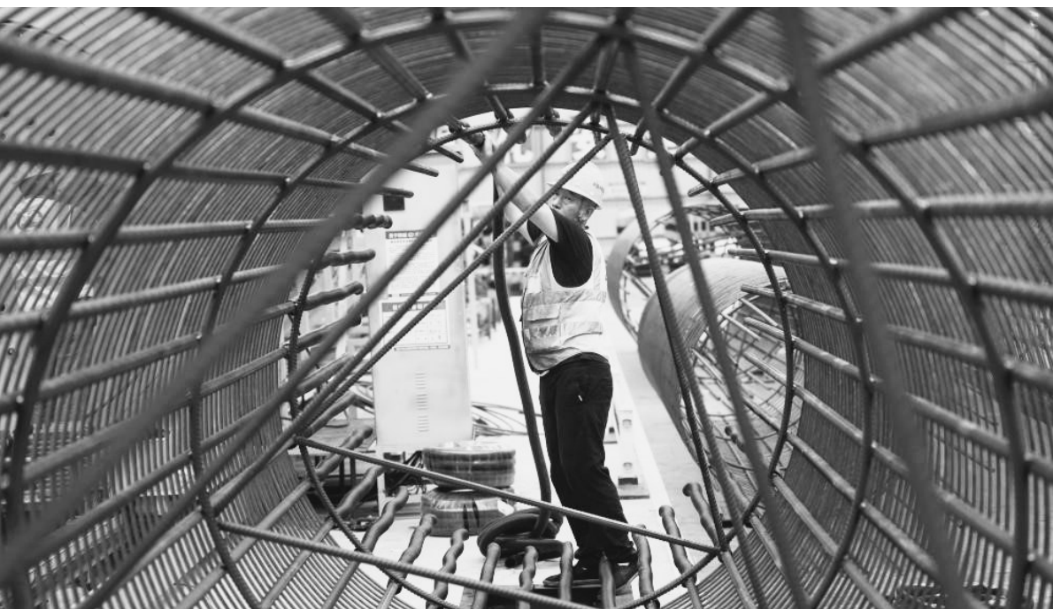
贵州黄桶至广西百色铁路(简称黄百铁路)贵州段近日进入全面施工阶段。黄百铁路全长约315公里,设计时速160公里,为国家Ⅰ级单线电气化铁路,预计于2028年建成通车。项目建成后,将进一步完善西部陆海新通道布局。图为中铁五局的建设者在生产黄百铁路望谟河特大桥所需要的钢结构部件。
