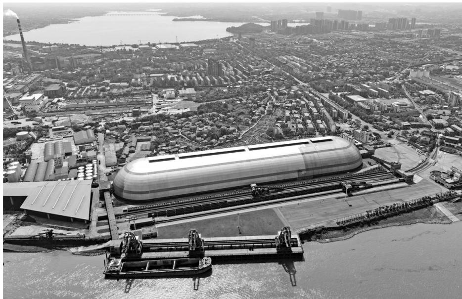
图为无人机航拍的湖南省岳阳城陵矶港口的长江流域首个巨型“胶囊式”全封闭散货仓库。该设施建成4年来，对港口散货进行全封闭堆存，从根本上解决了粉尘外溢、撒漏和扬尘等污染问题，以“生态优先、绿色发展”理念，推动了“黄金口岸”产生“黄金效益”，实现了环保和效益双提升。
