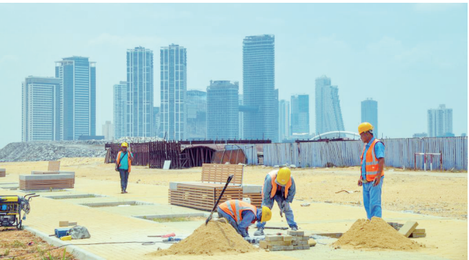
工人在斯里兰卡科伦坡港口城的施工现场进行作业。 新华社记者 徐钦 摄
