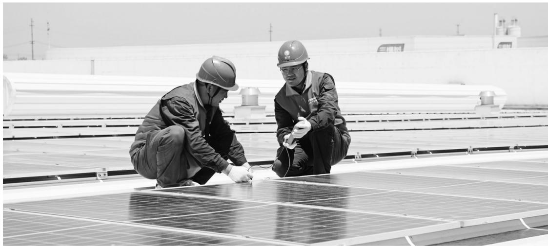
夏日来临,安徽省明光市在企业厂房屋顶建设的“屋顶光伏电站”迎来发电高峰期。安徽省明光市供电公司技术人员在安徽三棵树涂料有限公司的厂房屋顶对光伏电站进行巡视检查,保障发电设备稳定发电。
