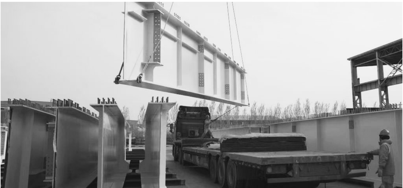
河北省秦皇岛市山海关区中铁山桥集团有限公司生产车间近日十分繁忙,工人们忙着生产今年的桥梁订单。目前该公司在建项目有狮子洋大桥、加拿大帕特洛桥、常泰长江大桥等多座大桥建造。图为该公司工人将建造完成的桥梁组件装车,准备交付客户。
