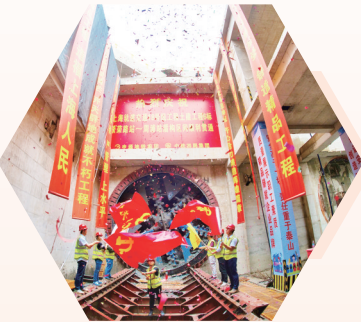
上海地铁18号线土建工程6标繁荣路站一周浦站盾构区间贯通庆祝仪式
