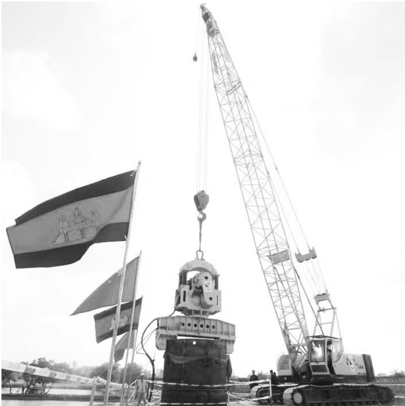
中国企业承建的柬埔寨百达隆巴萨河大桥项目2月19日在金边举行开工仪式。百达隆巴萨河大桥项目位于金边市南部，全长1650米。项目由上海建工集团股份有限公司承建，计划于2027年建成通车。图为工程车辆在柬埔寨金边的百达隆巴萨河大桥项目现场施工。
