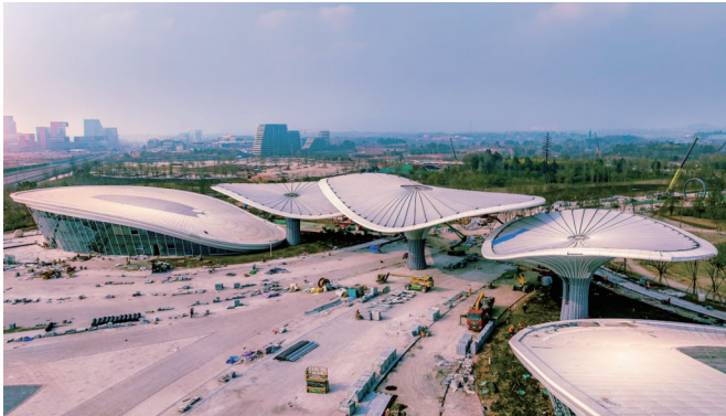
建设中的综合服务馆
