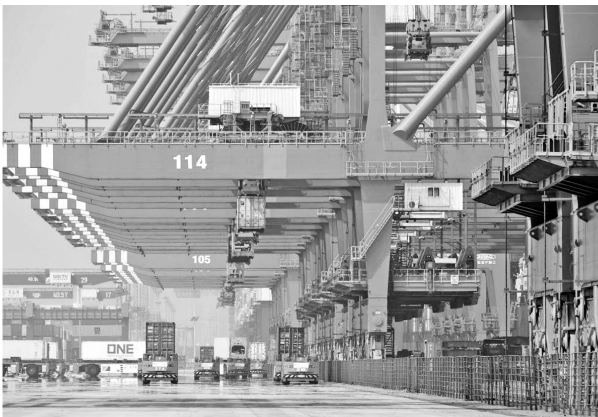
山东港口青岛港全自动化码头自主研发的智能管控系统A-TOS日前完成提质增效技术升级,助力装卸作业更加高效智能,码头单台桥吊昼夜(5月14日8点到5月15日8点)在港装卸集装箱量突破1100TEU,达1192TEU,比全球同类码头的单桥吊昼夜装卸效率高出19%。图为山东港口青岛港全自动化码头进行装卸作业。
