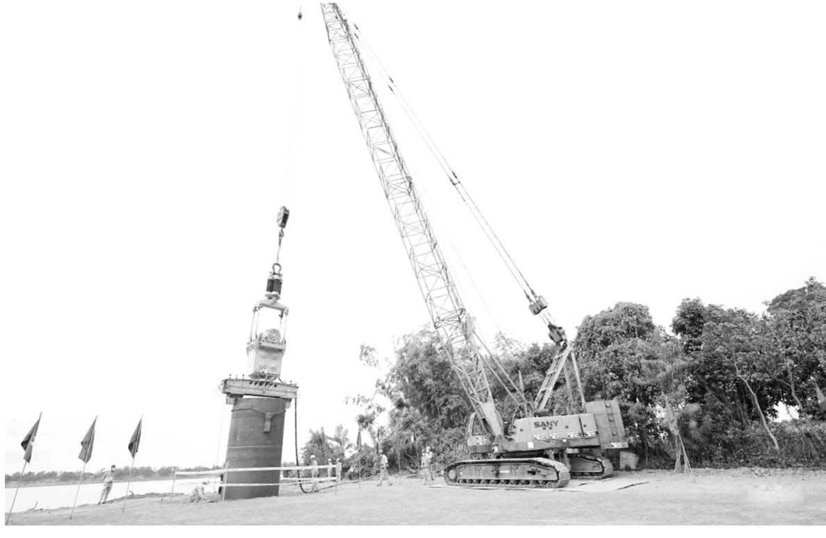
由中国进出口银行承贷、上海建工集团股份有限公司承建的柬埔寨桔井湄公河大桥及接线公路项目日前在桔井举行开工典礼。图为在柬埔寨桔井市拍摄的中企承建大桥工地。
