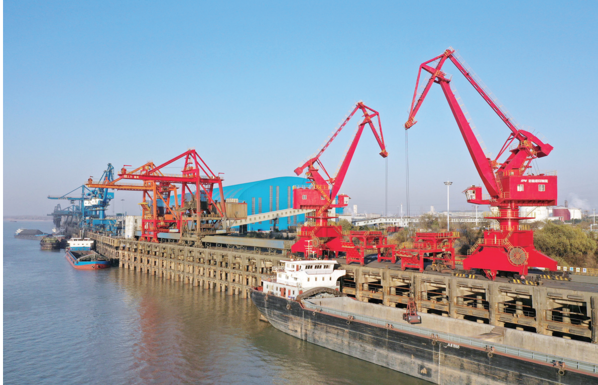
连日来,安徽铜陵港按照疫情防控“新十条”要求,落实落地各项保通保畅工作机制,保障长江港口环节供应链物流畅通,为当地经济发展贡献力量。图为港口机械在铜陵港长江望帽山港区装卸物资。中新社发 CCNPS/过仕宁 摄
