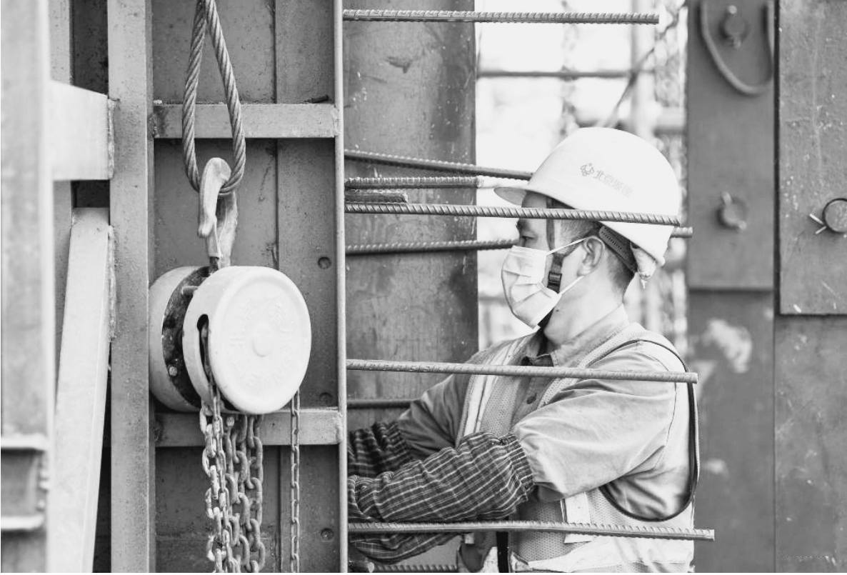
今年以来,重庆市璧山区通过建立协调机制、主动靠前服务、加强监督管理等举措,帮助相关重点交通基础设施项目解决用工、用地、原材料供应、交通运输等方面的困难,有效助力重庆市级重点交通基础设施项目顺利推进。图为工人在重庆城轨快线璧铜线璧山段施工现场作业。
