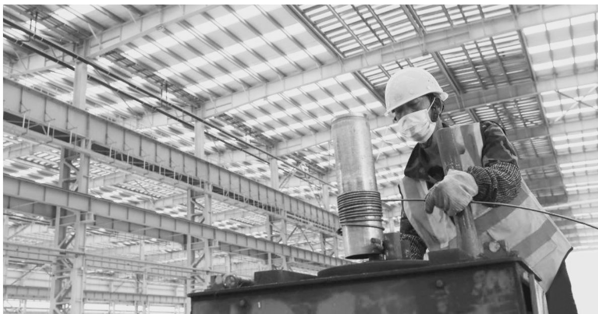
由中建二局参与承建的中船长兴造船基地二期工程建设近日取得新进展，船体联合车间首台大型设备主体结构吊装顺利完工。中国船舶长兴造船基地二期于2021年1月正式开工，规划建筑面积46万平方米，计划于2023年底建成。图为工人在中船长兴造船基地二期工程船体联合车间内制作钢筋结构件。
