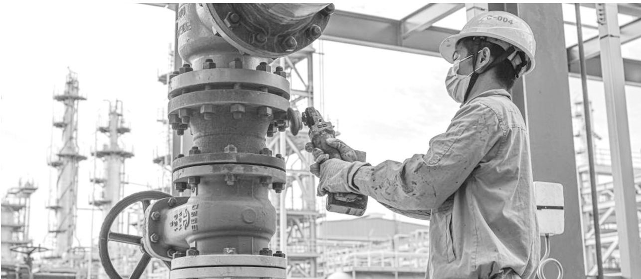
目前，在海南自贸港东方临港产业园，海南精细化工二期工程丙烯腈系列装置项目进入收尾施工阶段。该项目是海南省重点项目。图为工人在该项目工地施工。 新华社记者 蒲晓旭 摄
