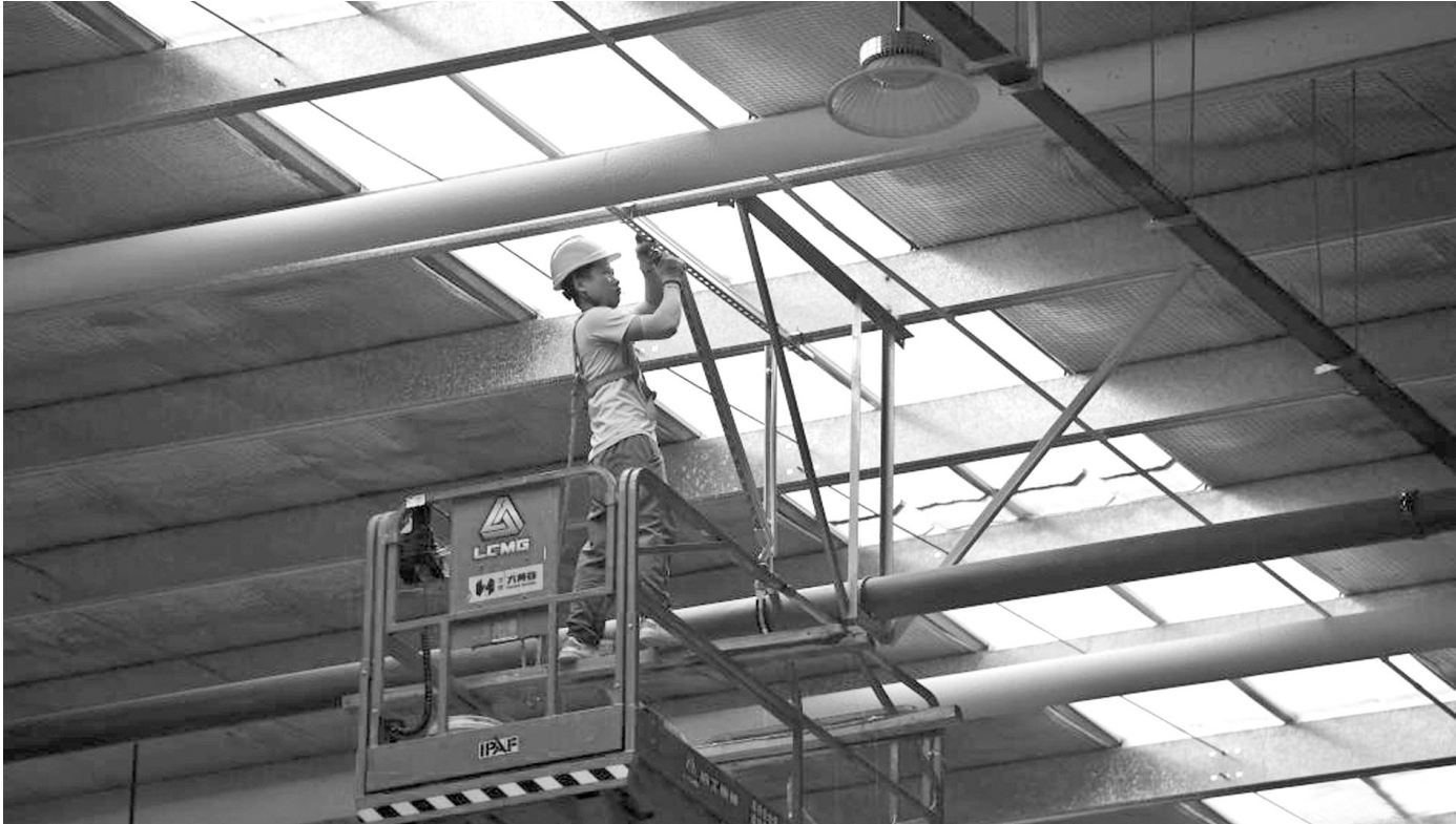
9月20日,广西南宁国际铁路港电商物流区快运处理1号仓主体完工。南宁国际铁路港电商物流区分为快运处理仓、速运处理仓两个作业型仓库集群。图为工人在南宁国际铁路港电商物流区施工。新华社记者 陆波岸 摄
