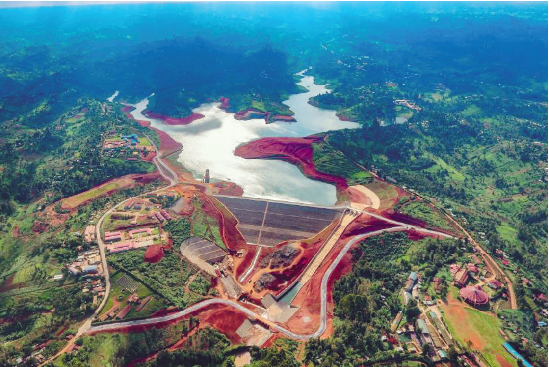
由中国企业承建的肯尼亚卡瑞曼纽大坝供水项目近日揭牌,这标志着该项目全面进入交付阶段并投入运行,将极大缓解肯尼亚首都内罗毕及周边城镇近百万人口用水问题。据悉,该项目是集大坝、水处理厂和管线于一体的综合水利项目,大坝的水库库容2640万立方米,水厂日处理量7万立方米。图为卡瑞曼纽大坝。
