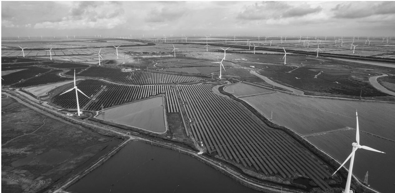
江苏省盐城市大丰区沿海滩涂“风光渔”产业示范基地,集风力发电、光伏发电、水面养殖为一体的“风光渔”立体综合项目,景色秀丽。中新社发 钟鑫旺 摄
