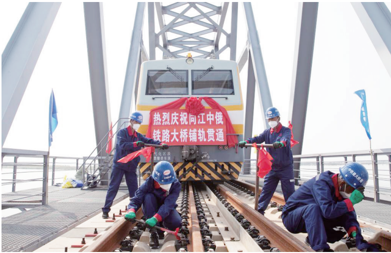
图为工人在同江中俄黑龙江铁路大桥施工现场进行施工。 (新华社记者 张涛 摄)
