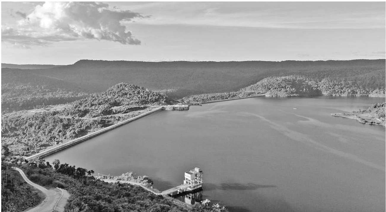
柬埔寨大地的崇山峻岭中,一座座中资企业投建的现代化水电站在过去十几年陆续投产,不仅为柬埔寨经济社会发展提供源源不断的清洁动力,也推动柬能源行业实现绿色转型。分析人士认为,作为柬埔寨重要发展伙伴,中国近期提出的“双碳”目标,将为柬埔寨清洁能源发展带来新机遇。图为位于柬埔寨戈公省达岱河的达岱水电站。
