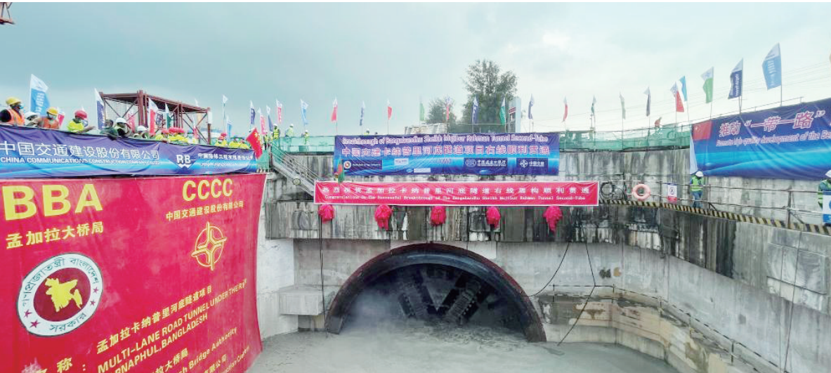
由中国交通建设股份有限公司(中国交建)承建、中国路桥工程有限责任公司负责实施的的卡纳普里河“孟加拉国隧道”项目近日实现右线隧道掘进贯通。整个项目至此顺利实现双线贯通,标志着中企在海外实施的首条大直径水下盾构隧道项目取得突破性进展。图为10月7日在孟加拉国吉大港市的“孟加拉国隧道”项目现场。
