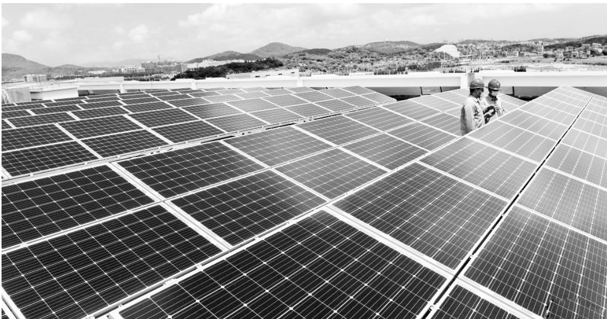
近年来，福建省围绕“节能降碳，绿色发展”的理念，在电力、交通、城建等方面大力推进以新能源为主体的新型电力系统建设和垃圾分类循环利用，推广低碳绿色建筑，倡导市民绿色出行。图为福建平潭综合实验区岚台物流园
