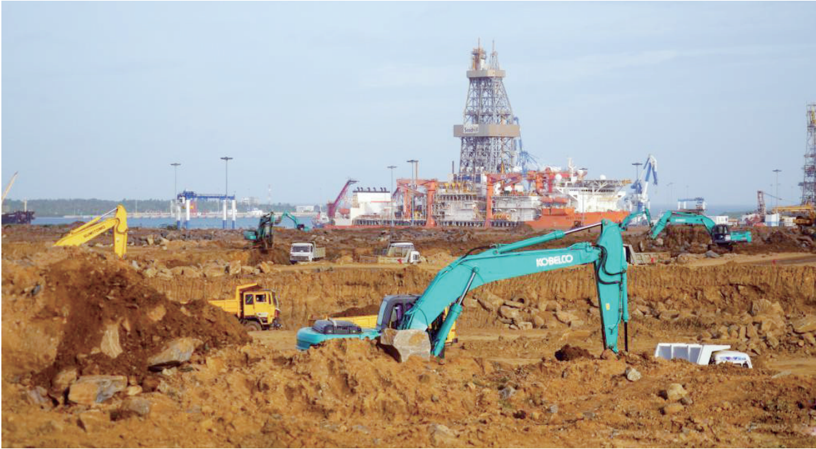
汉班托塔港是中斯共建“一带一路”重点合作项目,位于斯里兰卡南端,是一座综合性人工深水海港。两家中斯合营企业——汉班托塔国际港口集团有限公司和汉班托塔国际港口服务有限公司,分别负责项目的商业管理运营和公共服务。图为在汉班托塔港园区拍摄的锡兰轮胎厂施工工地。
