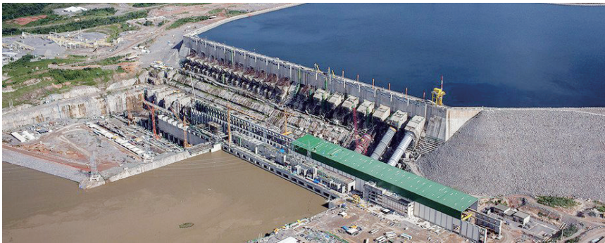
中企建设的巴西美丽山水电站项目
