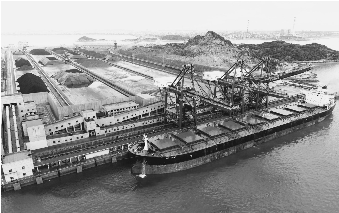
近日，装载着7.42万吨加拿大铁矿石的马绍尔群岛籍“大邦”轮，顺利靠泊福建交通集团罗屿港口9号泊位并卸船作业。这是台湾中钢集团在罗屿港口的首票进口铁矿石保税储运中转业务，也是台湾企业进口铁矿石首次在大陆港口实现保税中转。作为中国东南沿海最大的矿石码头，福建交通集团罗屿港口正联合台湾中钢集团打造台企散货物流储运基地。
