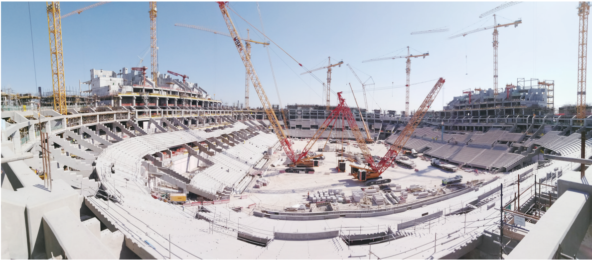
近日,随着卡塔尔卢赛尔体育场项目2区5层核心筒混凝土浇筑完成,中国铁建承建的2022年世界杯主体育场土建工程顺利完工。图为卢赛尔体育场项目内景。中国铁建 李子 李文德 供图
