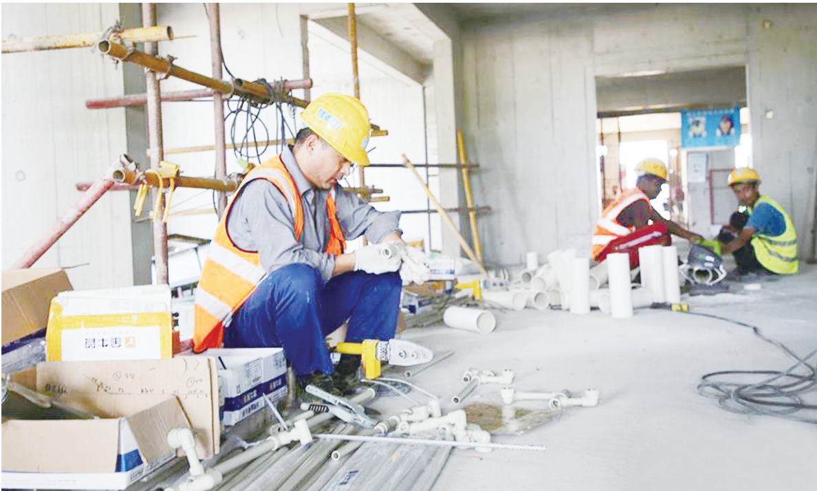
公益住房项目是中马两国在“一带一路”建设中的重要合作项目。马尔代夫首都马累面积仅约1.5平方公里,居住人口却超过10万。为了缓解马累拥挤的居住环境,中马近年来展开合作,在与马累隔海相望的胡鲁马累岛上建设公益住房。图为工人在公益住房项目施工现场工作。新华社记者 朱瑞卿 摄
