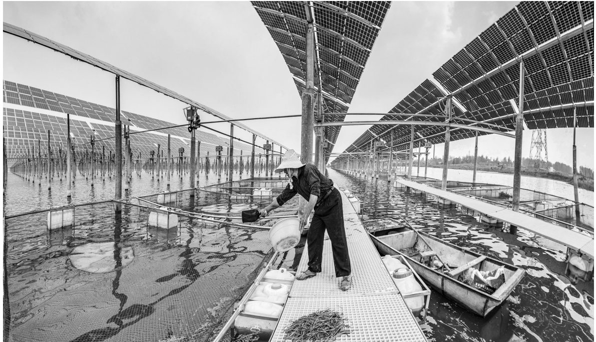
江苏省宿迁市泗洪县天岗湖乡光伏发电应用领跑基地采用“渔光互补”立体经营模式,打造光伏先进技术 with 特色渔业养殖相结合的示范基地。水面上方架设光伏板阵列,光伏板下方水域可进行鱼虾养殖,形成“上可发电、下可养鱼”的“渔光互补”发电新模式。这一项目为天岗湖乡的乡村振兴带来了活力。图为当地渔民在向网箱投放鱼饲料。 中新社发 张连华 摄
