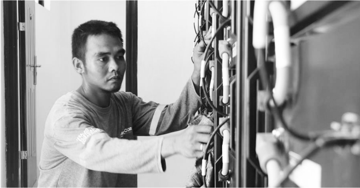
日前，中国国家电网公司驻菲律宾办事处在当地建成的一座太阳能发电站开始试运行。这一项目采取太阳能微电网集中供电，铺设在村中两个地势平坦处的200多块太阳能电池板共占地1000余平方米，发电容量76千瓦，电池储能容量390千瓦时。
