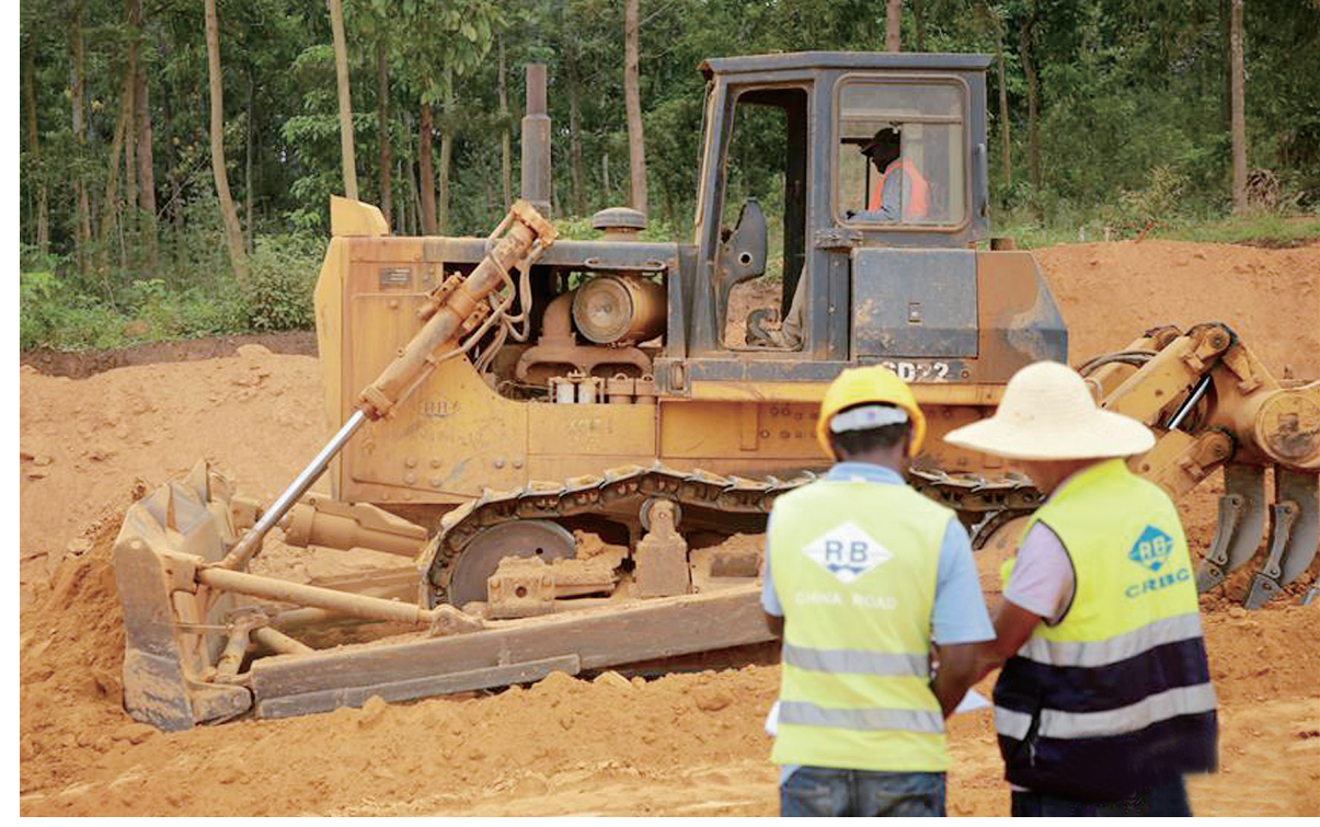
由中国进出口银行提供优惠贷款、中国路桥公司承建的卢旺达新机场路升级改造项目,将对其现有道路进行翻修并拓宽为双向四车道,全长约13.8公里。图为在卢旺达首都基加利,工人在现场施工。 新华社记者 吕天然 摄
