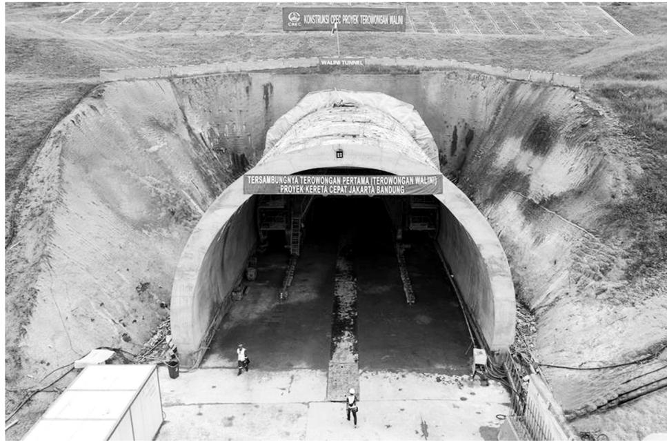
由中国中铁三局集团有限公司承建的印度尼西亚雅加达—万隆高铁项目瓦利尼隧道近日贯通,标志着雅万高铁建设取得阶段性重要进展,为全线加速建设奠定了坚实基础。新华社记者 杜宇摄
