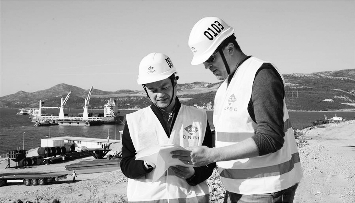
今年1月,克罗地亚总理普连科维奇视察由中企承建的佩列沙茨跨海大桥工程项目时,对中国企业的施工进度表示赞赏。5年多来,“一带一路”倡议在欧亚大陆落地生根,成为中欧战略合作新的增长点。图为中国籍工程师和克罗地亚籍同事在项现场查看图纸。新华社记者 高磊 摄
