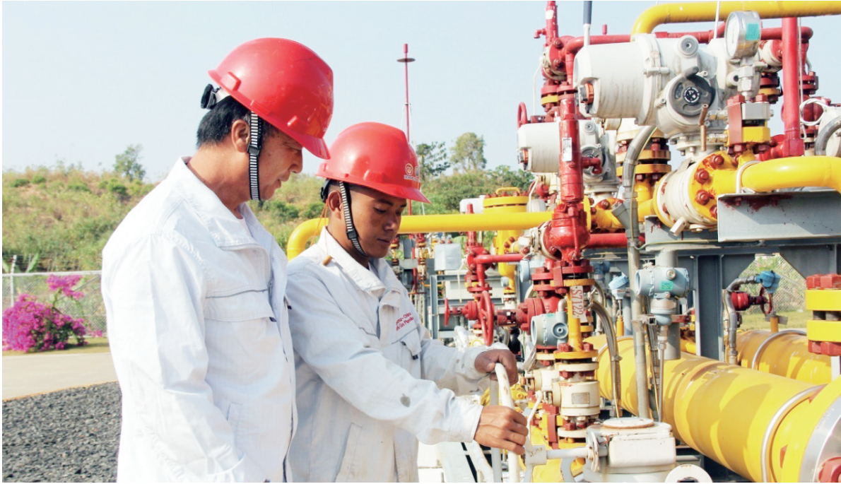
中缅天然气管道全长793公里,设置站场6座,年设计输量120亿立方米。该项目将使缅甸的经济、工业化和电气化水平得到提高,对缅甸的长期发展具有重要意义。图为中缅员工在新康丹泵站共同操作设备。
