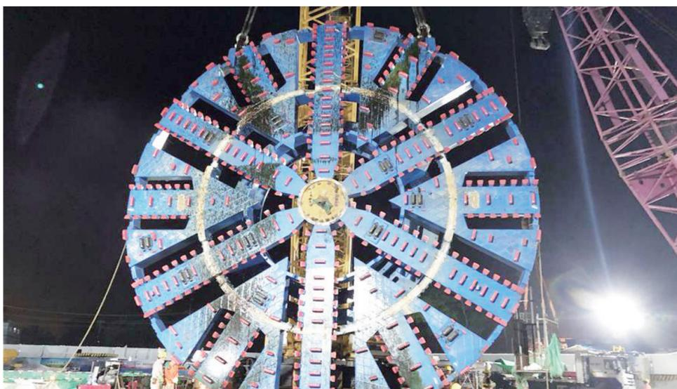
近日,孟加拉国卡纳普里河底隧道项目盾构机刀盘顺利完成下井工作。该盾构机由中国自主研发,直径约12米、长94米、重2200多吨,是中国出口海外的最大直径泥水盾构机。卡纳普里河底隧道项目由中国交建承建,于2017年底正式开工。图为在孟加拉国吉大港市的卡纳普里河底隧道项目现场,工作人员进行刀盘下井安装前的准备工作。新华社记者 刘春涛 摄
