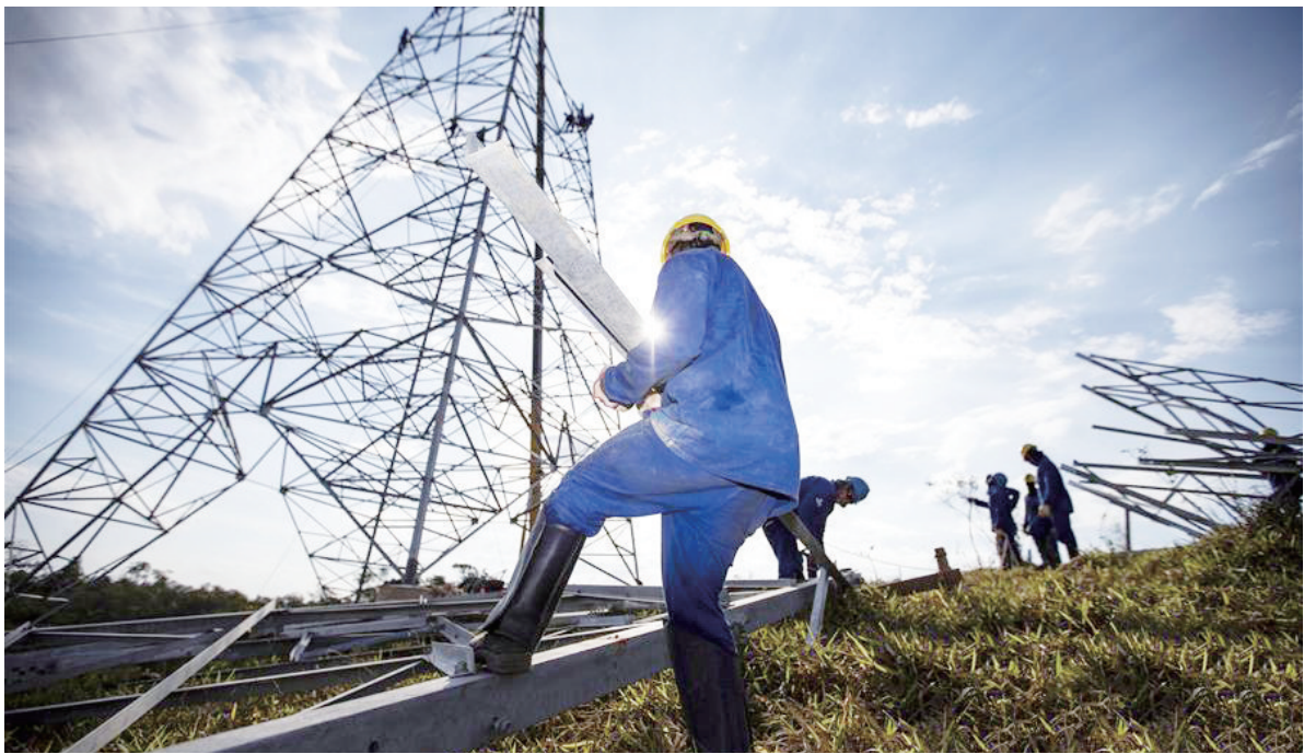
美丽山水电站是巴西第二大水电站,二期项目是中国国家电网公司首个在海外独立投资、建设和运营的特高压直流输电工程,也是该公司在拉美的示范工程。工程北起巴西北部的帕拉州,向南贯穿5个州,最终达到里约热内卢州,全长2518公里。图为工人在巴西美丽山特高压输电工程二期第九标段项目现场施工。
