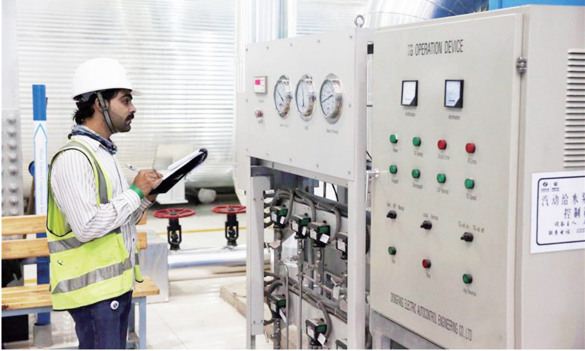
5年的发展与奋进,“一带一路”从理念转化为行动,连点成线到面,在广袤大陆上落地生根。卡西姆港燃煤电站作为中企承建、运营的中巴经济走廊首个落地的大型能源项目,现已成为了“一带一路”上的项目标杆。图为在巴基斯坦卡西姆港燃煤电站,一名当地工人监测仪器数据。
