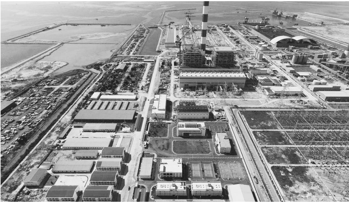
日前,由中国企业在越南投资规模最大的电力项目——越南永新燃煤电厂一期项目1号机组近日正式投入商业运营。该项目位于越南平顺省,由中国南方电网有限责任公司、中国电力国际有限公司和越煤电力有限责任公司共同投资。
