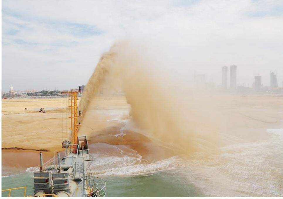
图为斯里兰卡科伦坡港口城项目施工现场,万吨沙号耙吸吹沙船正在吹沙。共有三艘从中国远道而来的耙吸吹沙船参与作业。新华社记者 朱瑞卿 摄
