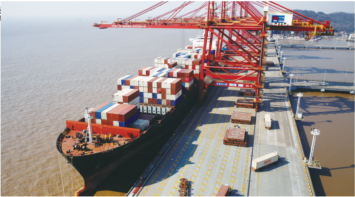
2月5日,宁波舟山港大浦口集装箱码头集卡奔忙,八台桥吊全部作业,一派繁忙的作业景象。据统计,截至1月31日,大浦口集装箱码头(舟山甬舟集装箱码头有限公司)1月份已累计完成集装箱吞吐量12.64万标箱,同比增长28.78%,月集装箱吞吐量首破12万,实现新年开门红。
