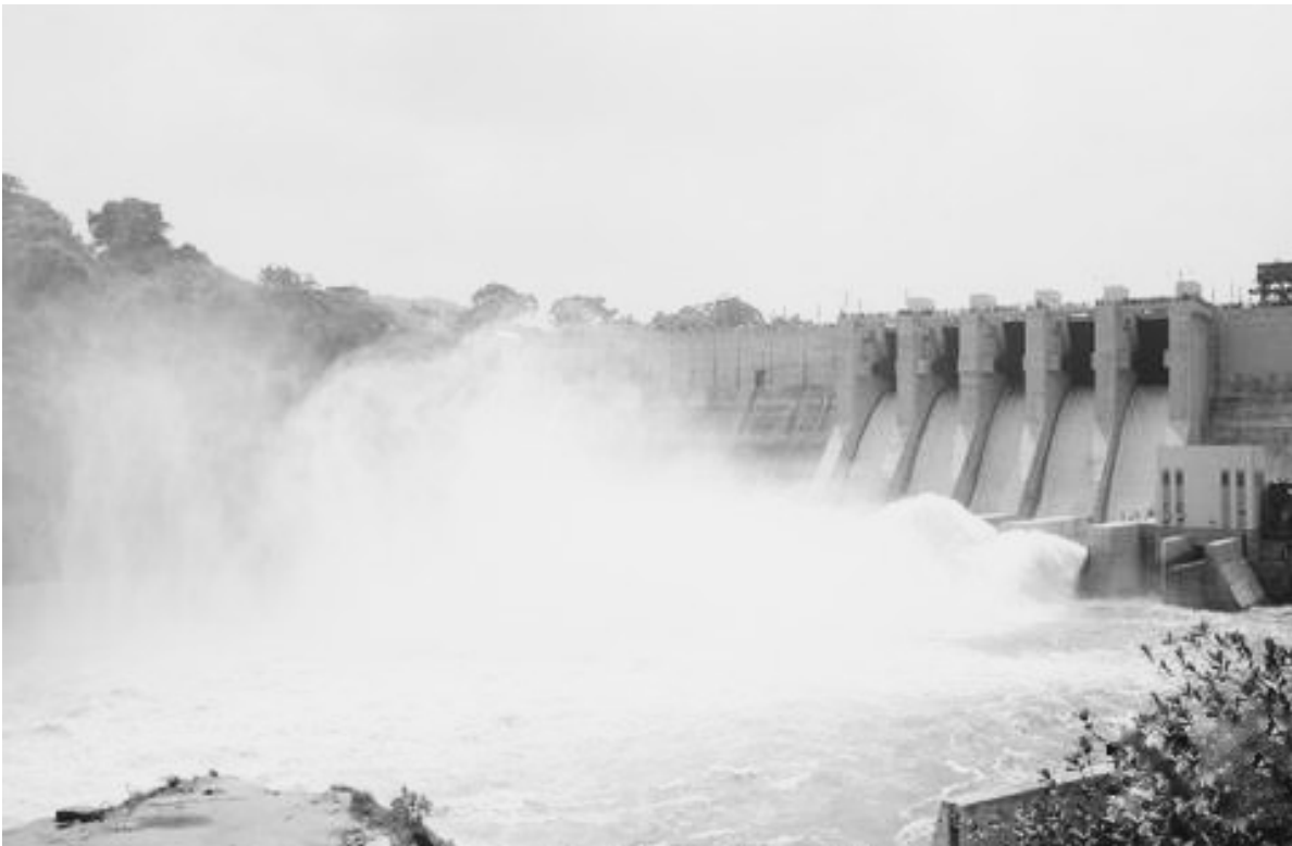
由中国企业承建的斯里兰卡中部莫勒格哈坎达水库项目于2012年7月开始建设,2017年7月全部完工。据了解,该项目是斯里兰卡最大规模的水利枢纽工程,其蓄水能力为5.7亿立方米,发电能力为25兆瓦。项目从南到北贯穿斯里兰卡,利用较大库容将雨季的贮水调节到旱季使用,将中部的水调节到北部使用。项目不仅解决了下游大片区域用水问题、提升了汛期防洪能力,还将明显改善区域供电质量。
