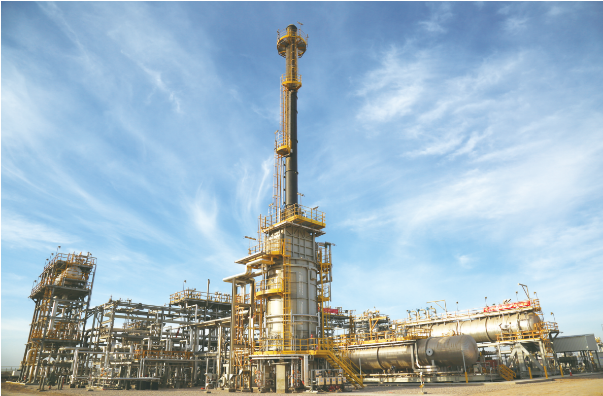
日前，中国石油天然气集团公司与埃克森美孚公司合作的首个EPC产能建设项目西古尔纳-1油田M130正式建成投产。 图为西古尔纳-1油田M130项目全景。
