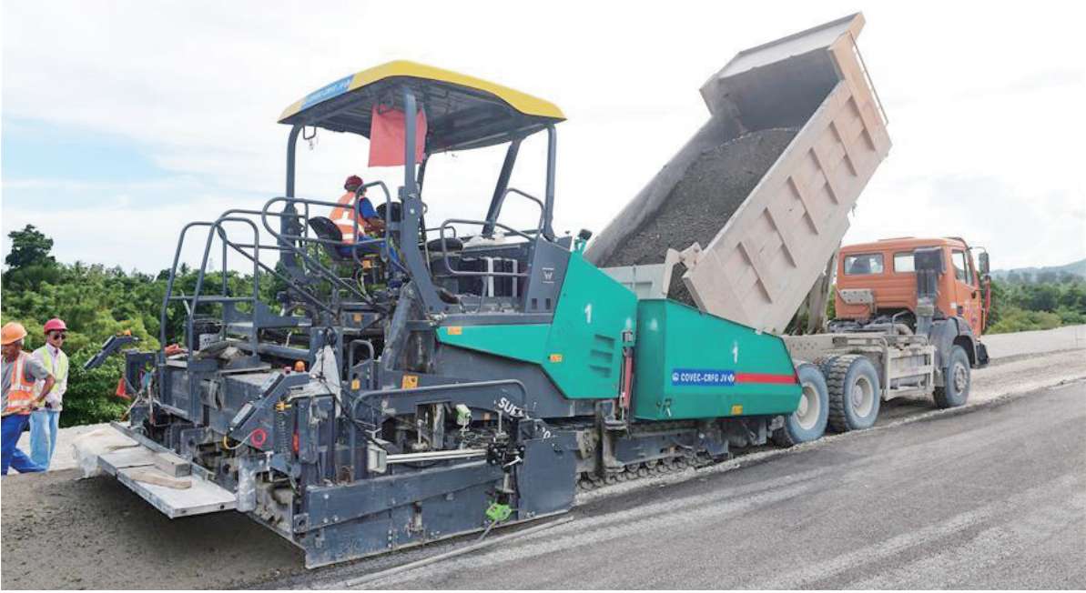
中铁国际集团中海外 中铁一局东帝汶联营体公司目前承建东帝汶高速公路项目一条长约30公里的标段,项目于2016年1月开工,预计2018年7月完工。图为工人在东帝汶苏艾高速公路项目工地上铺设沥青。
