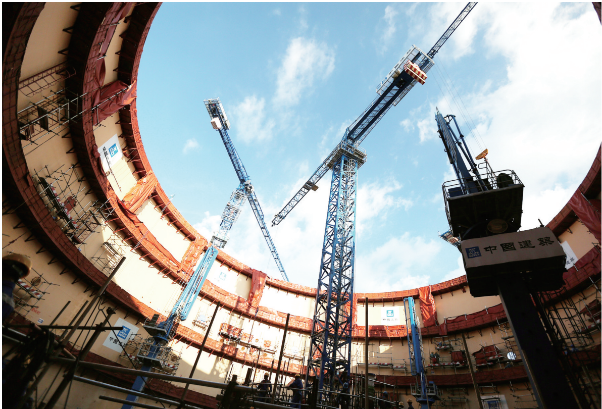
广西防城港核电二期工程在北部湾畔正在紧锣密鼓地施工中。该工程采用中国自主研发的第三代核电技术“华龙一号”,不仅是中国广核集团公司“华龙一号”示范工程,也是英国布拉德韦尔B核电站的参考电站。中建二局650多名专业工程师和近4000名技术工人正为这项“国之重器”而努力奋战,以最严苛的质量安全标准,为中国建造品质代言。
