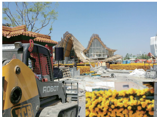
▲ 中国馆外园林建设施工现场。
