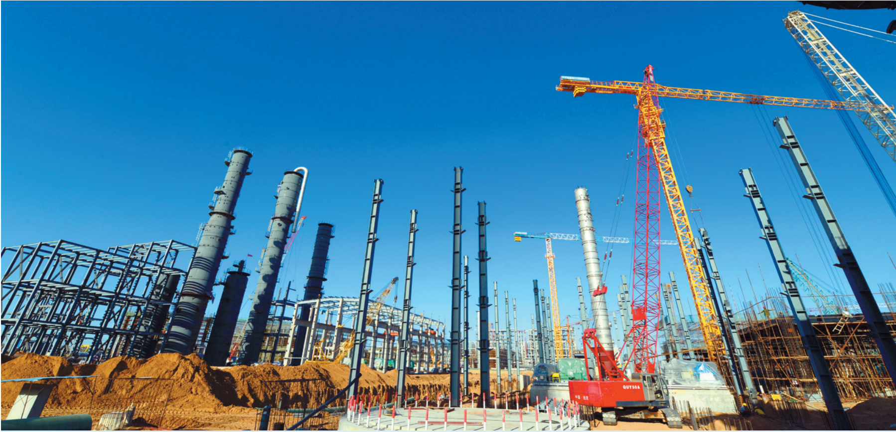
该公司锅炉、合成、净化、油品加工等五大界区设备安装紧锣密鼓进行中
