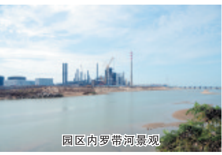
中海油东方石化股份有限公司DCC项目建设
